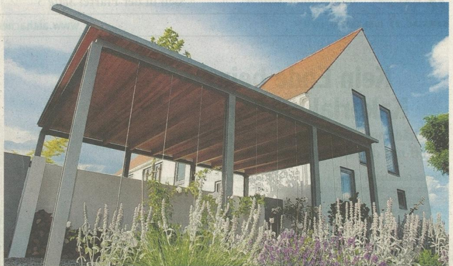
Nüchtern, praktisch. Birgit Rümmelein stellt ihr Haus in Hausnwies, St.-Jodok-Straße 13, im Rahmen der diesjährigen „Architektortouren“ vor als „traditionelles, regionales Bauen, zeitgemäß interpretiert“.
